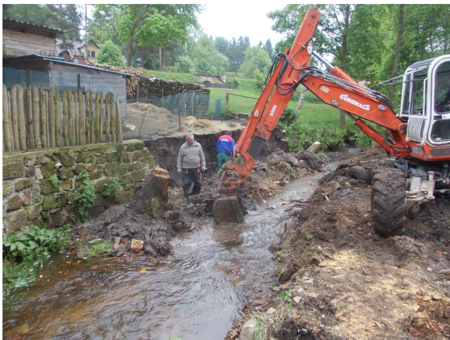
Obrázek 2 Výkop pro základy zdi při její opravě na dolním konci pseku v roce 2013
