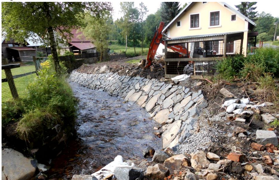
Obrázek 4 Kamenná rovnanina na horním konci úseku v roce 2013
